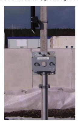
Die Ausschaltung erfolgt nach Freifahren der Ausschaltschleifen. Bei längeren Rangierarbeiten im BÜ-Bereich kann eine Dauereinschaltung mittels Rangierschalter vorgenommen werden.
